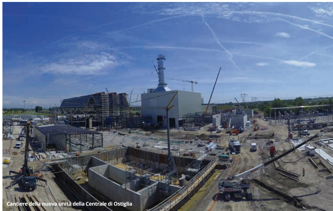
Cantiere della nuova unità della Centrale di Tavazzano e Montanaso
